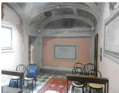
Vista d'insieme prima dei lavori
