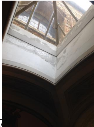
L'interno del lucernaio da restaurare
