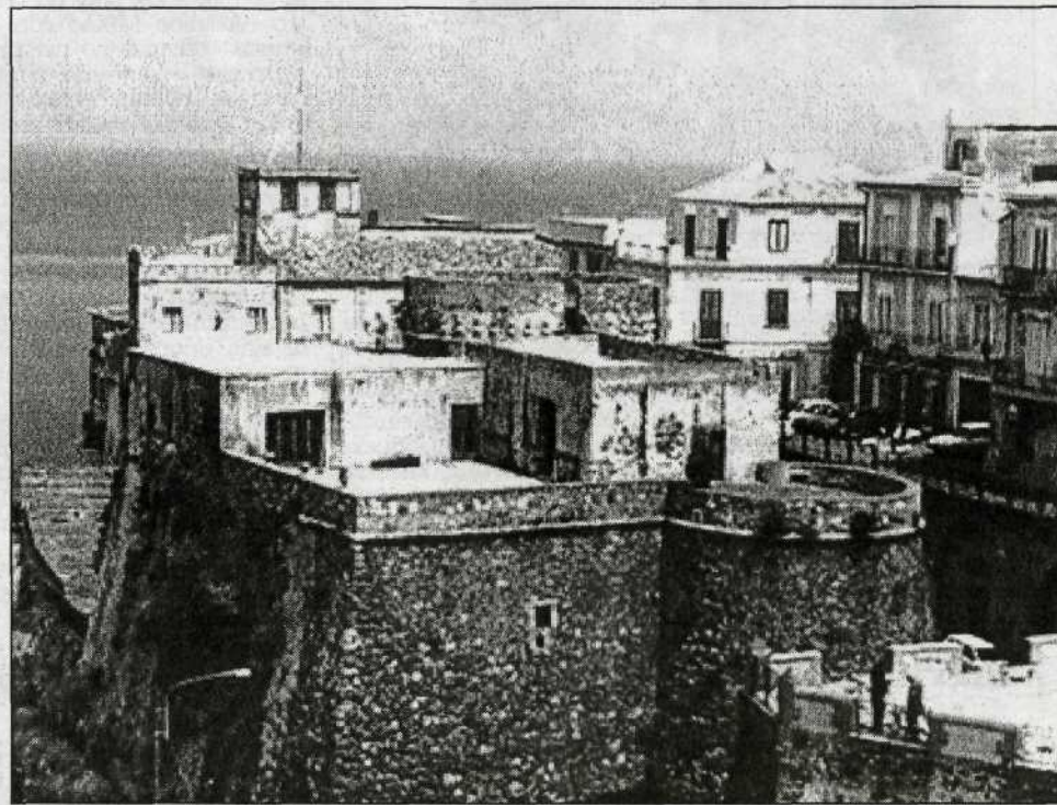
Pizzo - Il castello Murattiano ubicato in pieno centro cittadino
